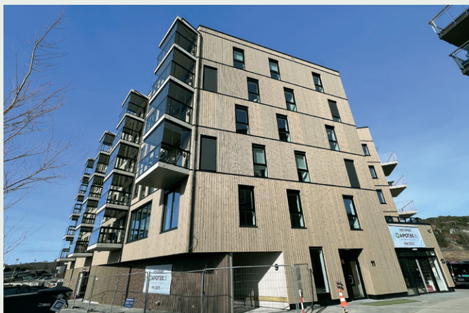
Det er benyttet trefasader på byggene.
