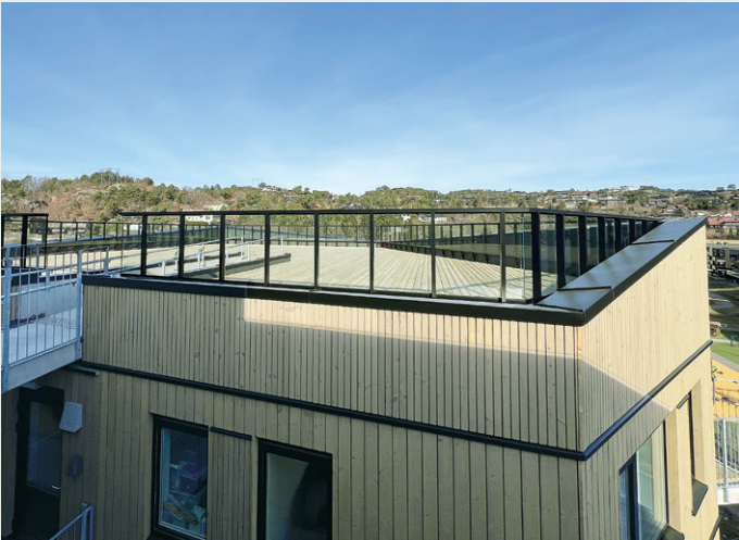
Takterrassen ligger på toppen av tårnet.
